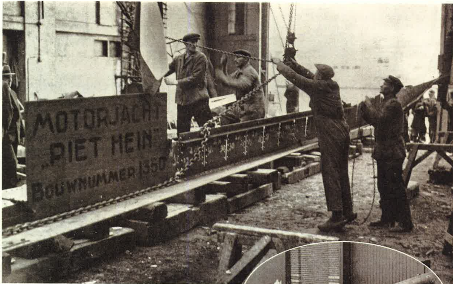
Op 25 Maart 1937 werd de kiel gelegd. Inzet: de voorsteven gereed voor den inbouw.
